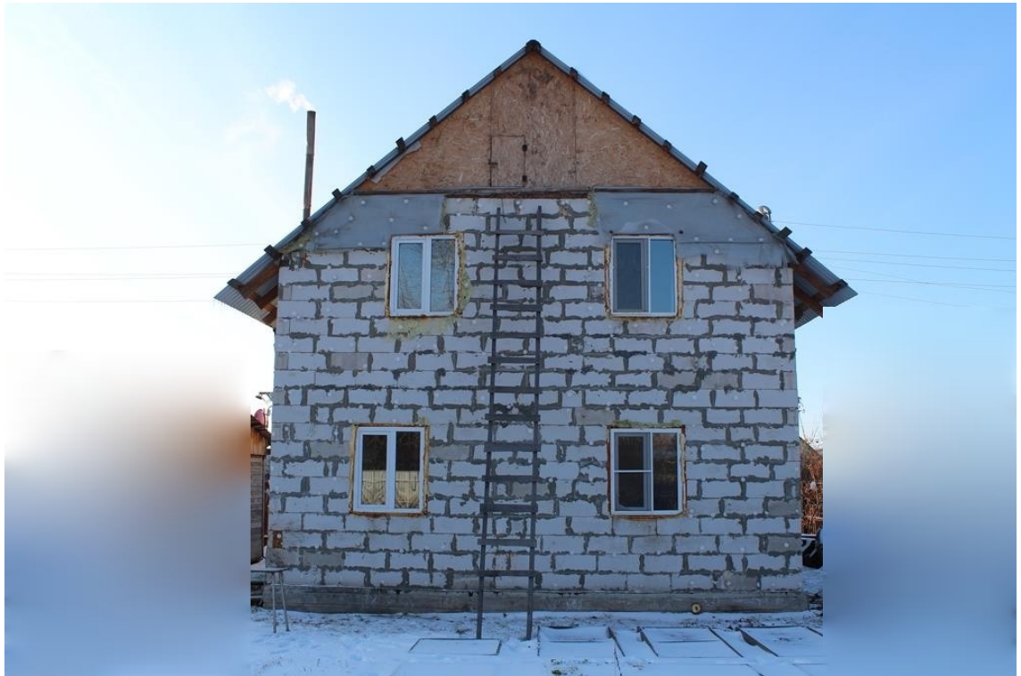
Фото 1. Фасад в осях А;1-3
