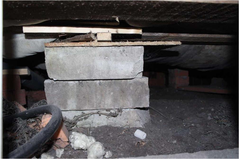
Фото 5. Опираие лаг перекрытия первого этажа
