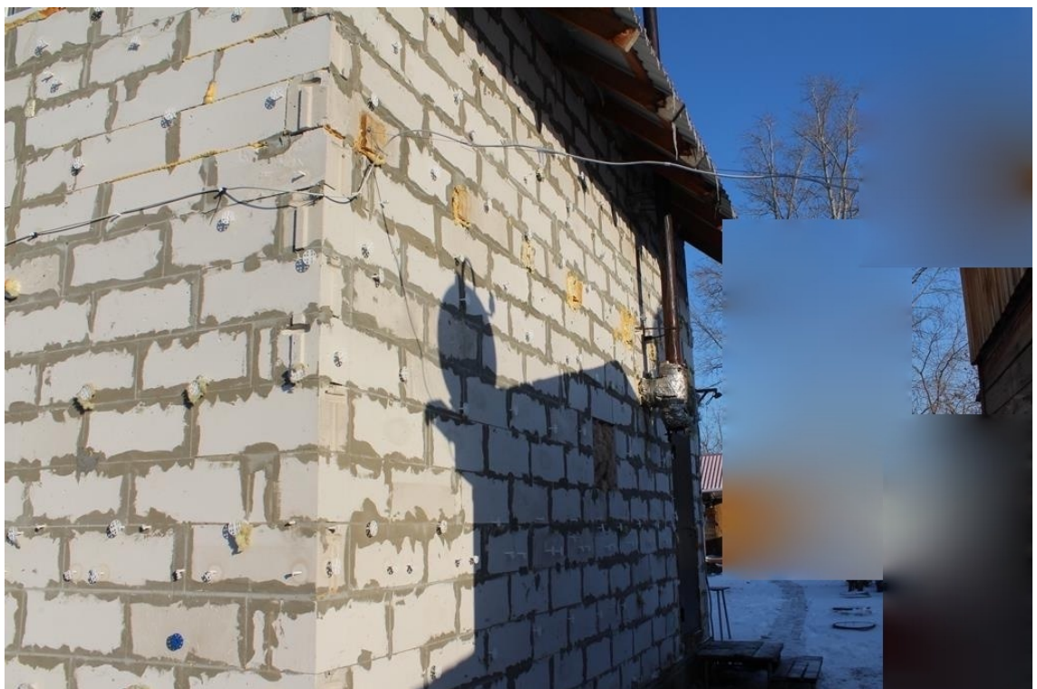
Фото 2. Фасад в осях 1;А-Б
